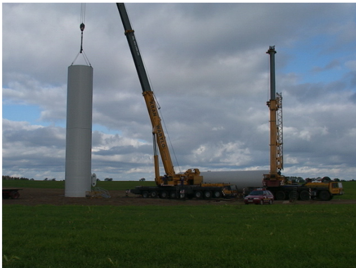
Fot. 2. Montaż wieży elektrowni wiatrowej z gotowych elementów (farma wiatrowa w Tymieniu, woj. zachodniopomorskie). 4
