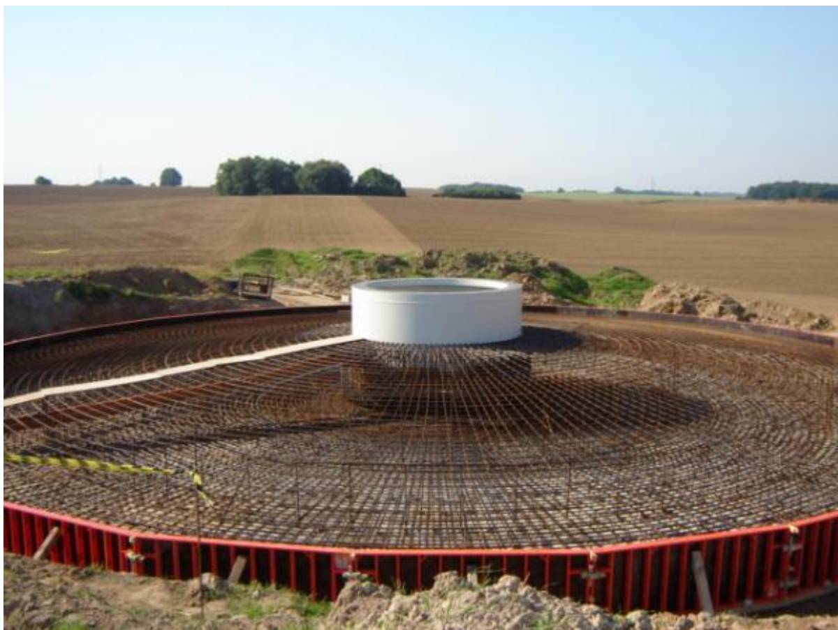
Fot.1. Przykład zbrojenia fundamentu elektrowni wiatrowej (farma wiatrowa w Tymieniu, woj. zachodniopomorskie) 3
