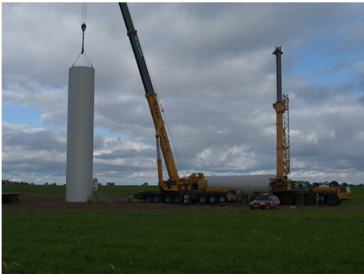
Fot. 2 Montaż wieży elektrowni wiatrowej z gotowych elementów (farma wiatrowa w Tymieniu, woj. zachodniopomorskie). (źródło: www.eez.pl )
