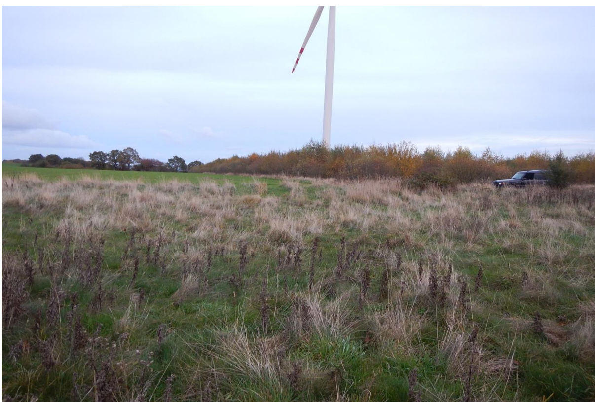
Fot. 6. Istniejąca turbina posadowiona na wschód od działki. W tle spontaniczny samosiew brzozy i wierzby porastający sąsiednią działkę.
