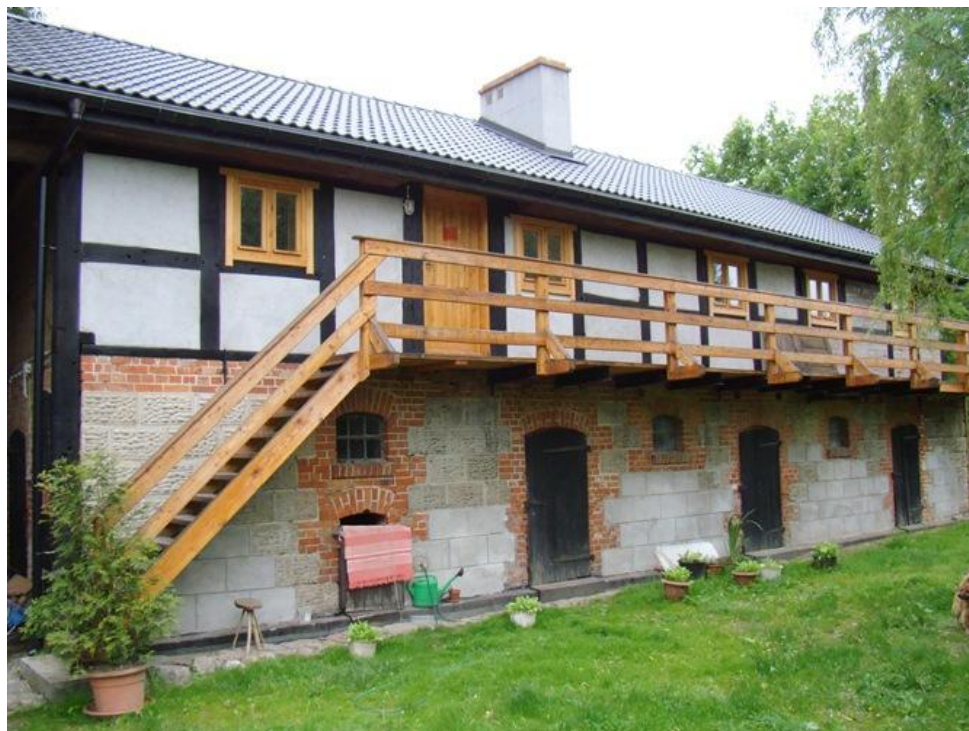
Słowino 76 – budynek bramny
