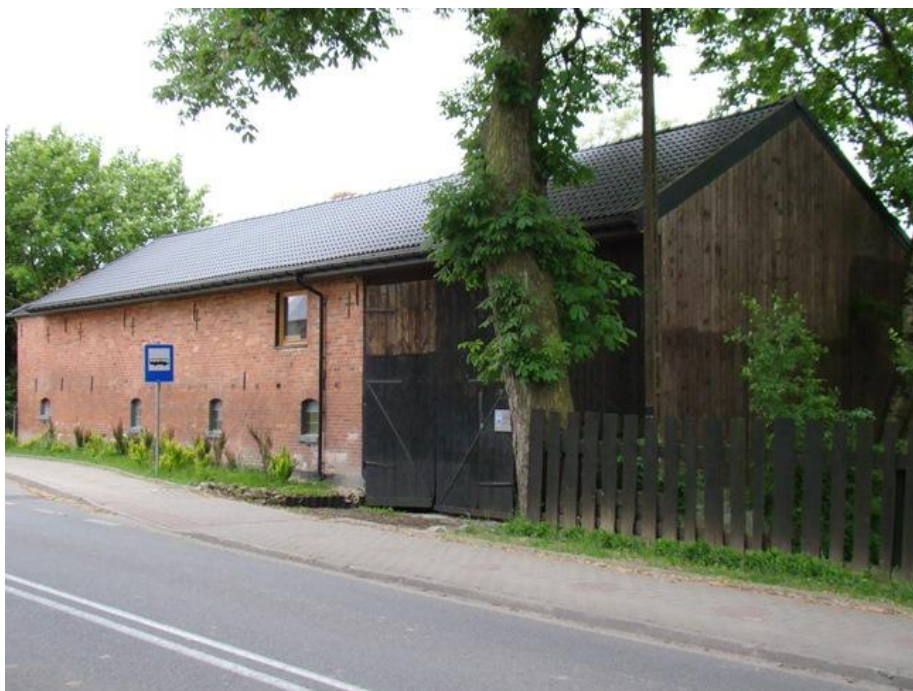
Słowino 76 – budynek bramny
