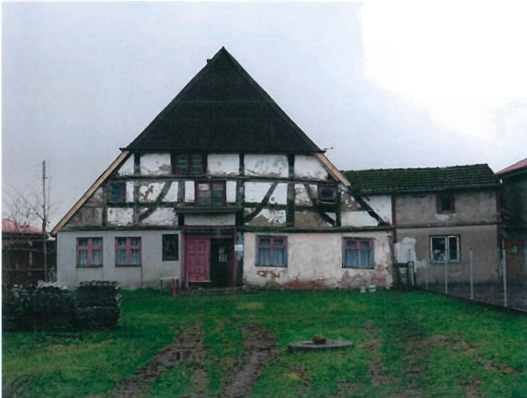
Krupy, remont dachu XVIII-wiecznej chałupy
