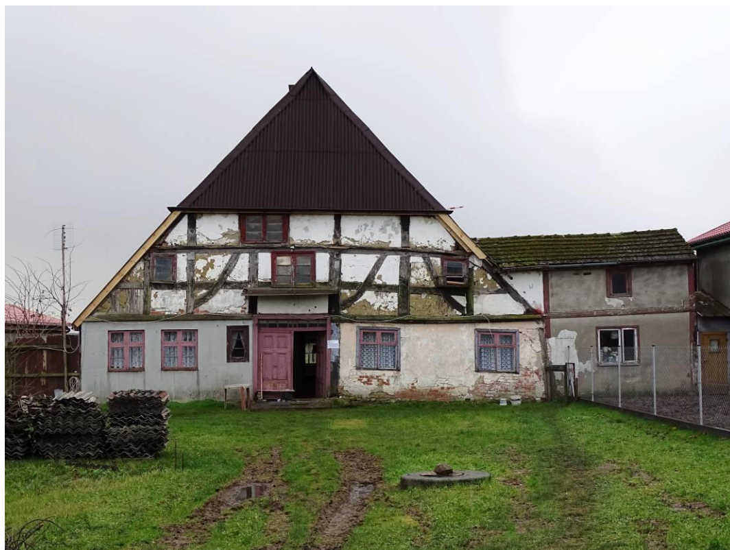
Krupy, remont dachu XVIII-wiecznej chałupy
