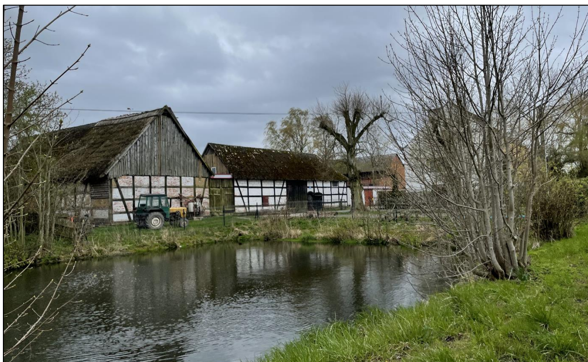
Ryc. 2.18. Budynek w zabudowie wzniesionej w technice ryglowej, obręb Cisowo, gmina Darłowo
