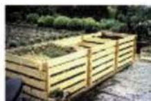
Kompostownik drewniany – zbudowany z desek – znacznie łatwiej, niż to wymaga przepisów, w ziemi materiałami budowlanymi.
