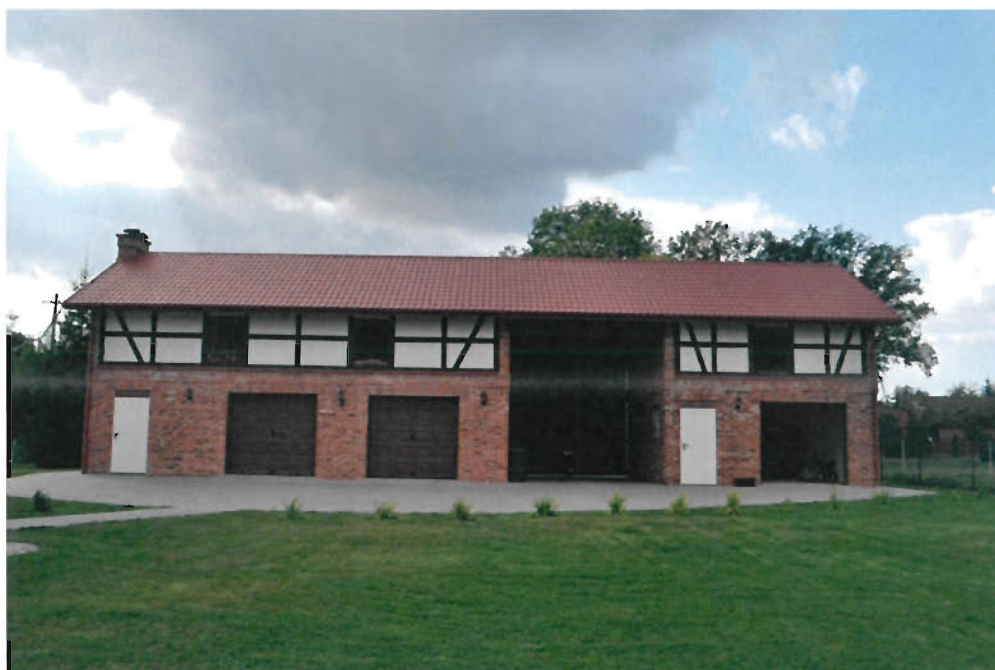
Wiekowice 62 – budynek bramny
