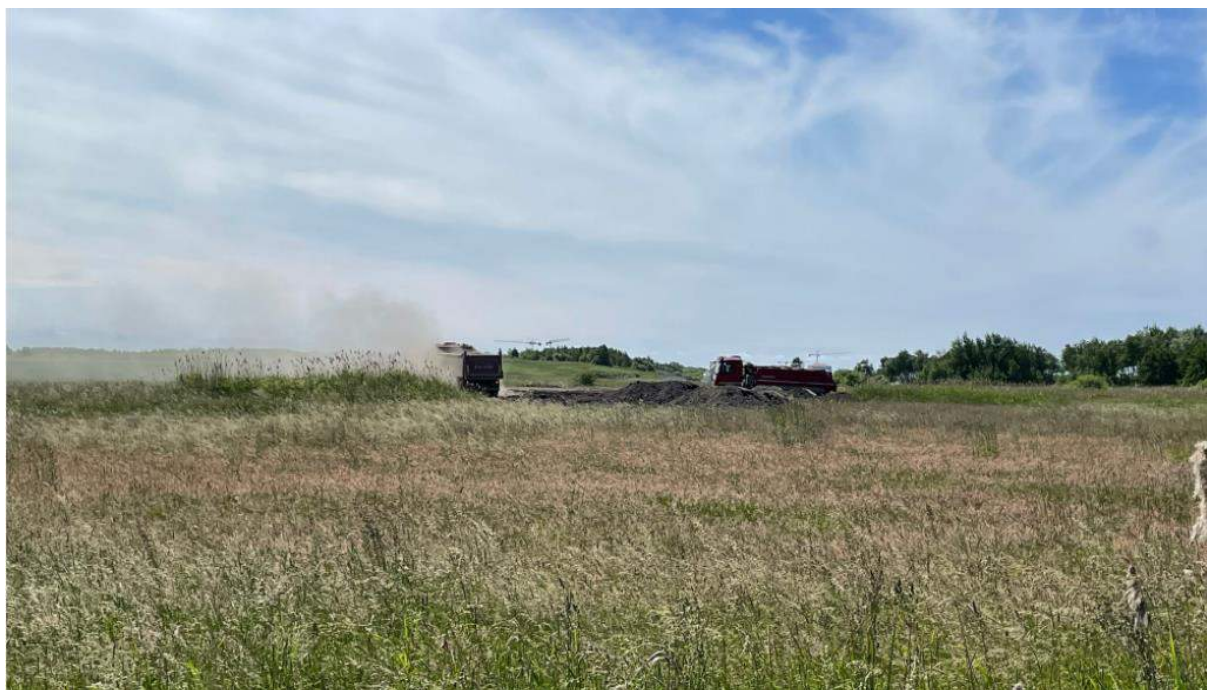
Fot. 4. Prace budowlane w obrębie Kopań na terenach przeznaczonych w projekcie studium pod rozwój zabudowy [fot. 2021 r.]
