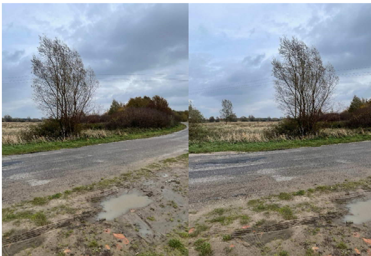
Rysunek 68. Widok na dz. nr 76/2, obręb Wicie - stan na 27 października 2021 r. [źródło: zbiór własny]
