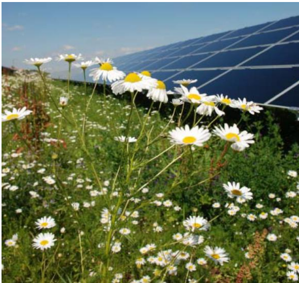
Fot. 11 Zbiorowisko o charakterze łąkowym na terenie farmy fotowoltaicznej (źródło: Peschel T., Solar parks – Opportunities for Biodiversity. A report on biodiversity in and around ground-mounted photovoltaic plants, Renew's Special Issue 12/2010 )
